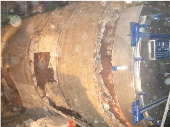
**Figura 15** – Isolamento térmico de caldeira
