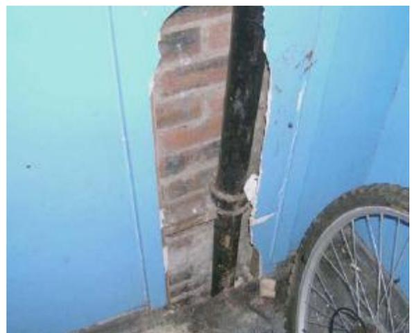
**Figura 14** – Painel de isolamento contendo amianto
