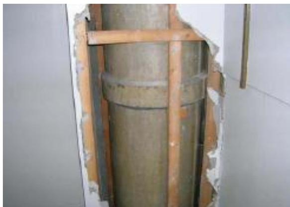
**Figura 5** – Caixa de painéis de isolamento e tubagem de fibrocimento
