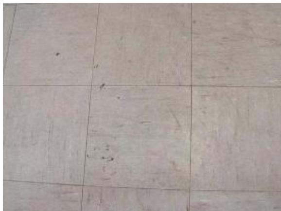
**Figura 7** – Revestimento de piso em mosaico contendo amianto
