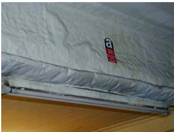
**Figura 12** – Estrutura de aço com isolamento de amianto (protecção ignifuga)
