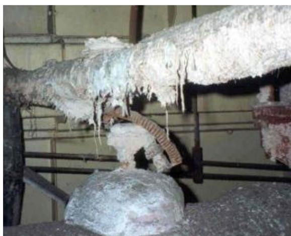
**Figura 9** – Isolamento térmico de conduta de vapor
