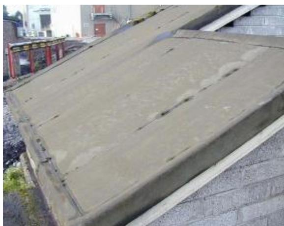
**Figura 8** – Mantas de feltro para isolamento de coberturas
