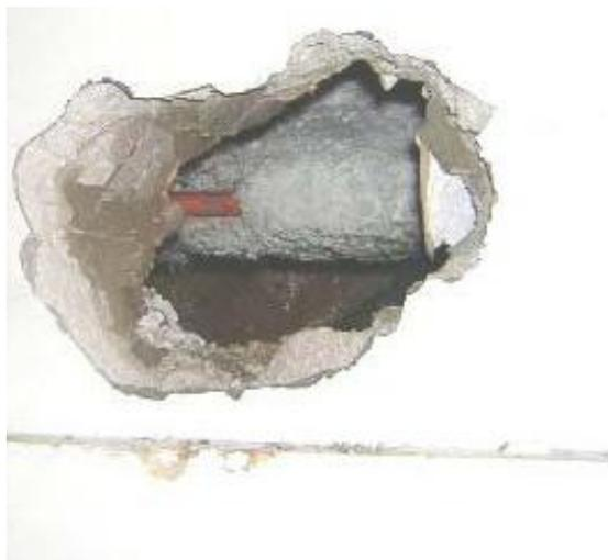
**Figura 4** – Isolamento de tubagem embutida na parede
