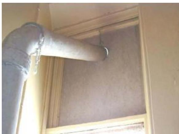
**Figura 6** – Conduta em fibrocimento com selantes de junta em cordão de amianto. A conduta atravessa um painel também com amianto
